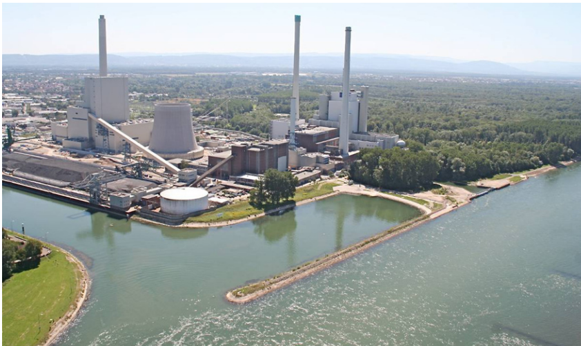
Rhein Dampfkraftwerk Karlsruhe (RDK)
